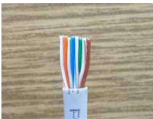
Рисунок 4 – Распрямление проводов
